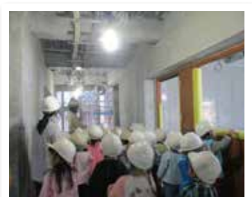
新園舎建設現場見学
